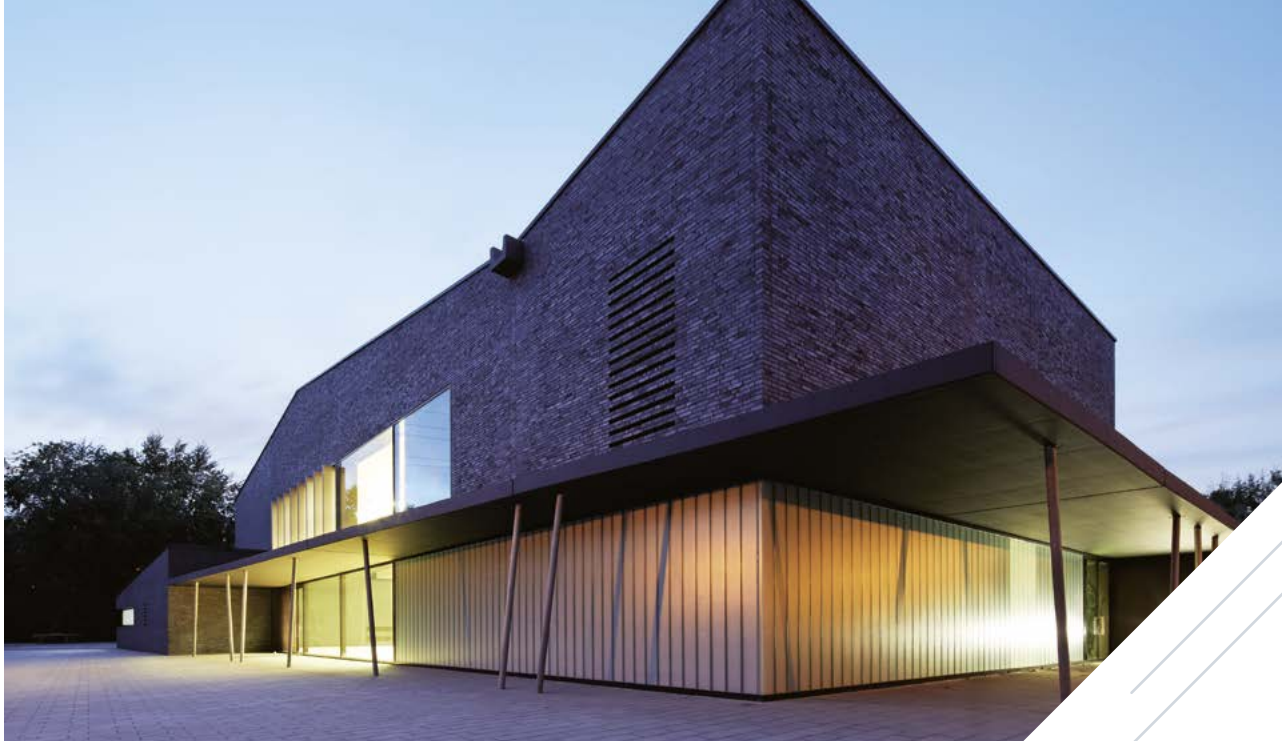
Sporthalle Stadtteilschule Bergedorf
