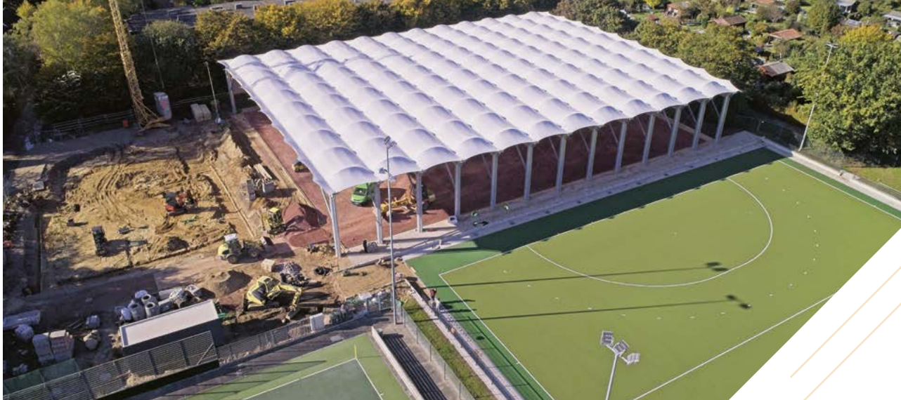
BSP Hockey im Bau
